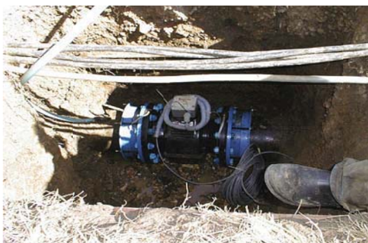
شکل ۴-۹. نصب فنی زیر زمین با استفاده از فلنج لغزان
