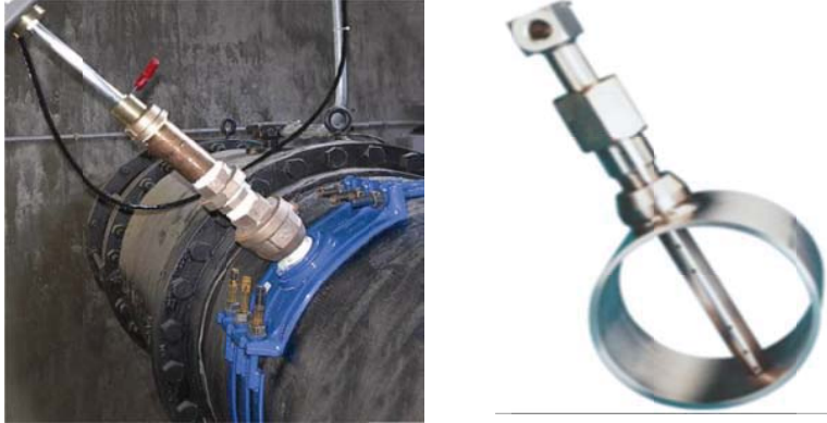
شکل ۳-۷. فلومترهای بانصب تزریقی
